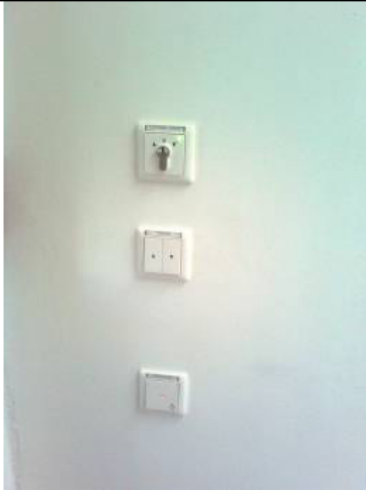
Bild 5: Zentraler Lichtschalter für die Dreifachhalle im Stiefelgang vor den Umkleiden
